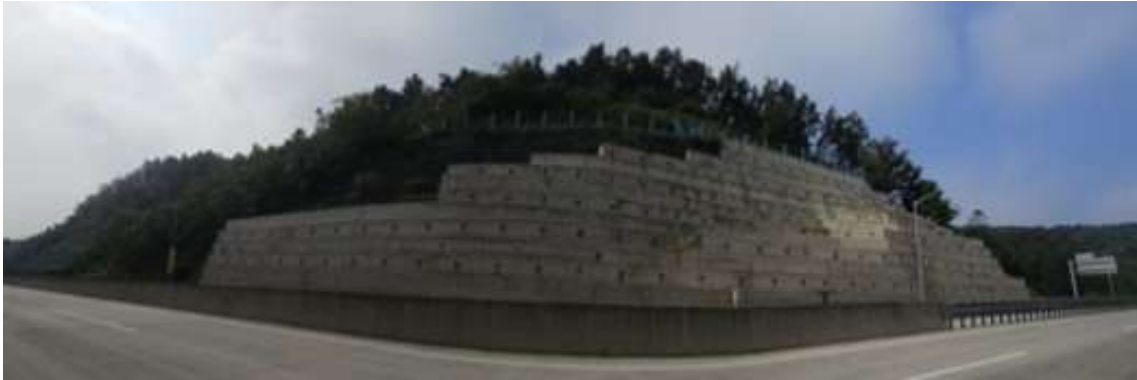
영천절토 31 (관리이정 40.025~40.175km / 5공구 STA.3+790~8+940)
